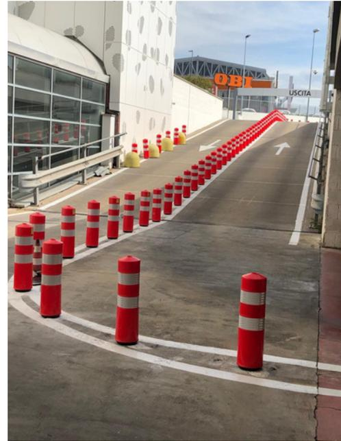
**Delineatore di margine** denominato **Faro Segnalatore**, costituito ad alta pressione del polimero termoplastico in uno stampo. I coloranti utilizzati per ottenere le diverse colorazioni sono privi di metalli pesanti. il Faro Segnalatore è estremamente flessibile e recupera tempestivamente la sua forma originale in caso di schiacciamento, senza rompersi o frammentarsi, eliminando il rischio di presenza di elementi metallici o parti rotte sulla strada.
